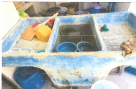
Foto 1: REPARACIÓN O SUSTITUCIÓN DE ÁREA DE COCINA sustitución pila, nivelada y con conexiones hidráulicas.
