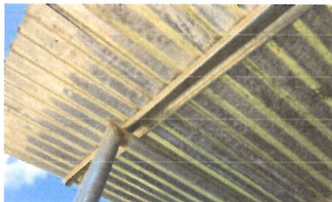
Foto 2: ESTRUCTURA DE TECHO Sustitución de estructura metálica para soporte de cubierta de lámina incluyendo perfiles para vigas, travesaños, sujeta con tornillería; corte, soldadura y anclaje de la estructura portante. PATIO, COCINA Y BAÑOS
