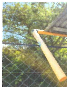
Foto 6: CANALES Y BAJADAS DE AGUA PLUVIAL sustitución de bajantes para evacuación de aguas pluviales anclada por medio de abrazaderas y tornillos. Aulas y baños
