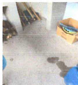
Foto 4: PISO Sustitución de piso de concreto con acabado liso por piso cerámico, incluyendo preparación de superficie y nivelación. Cocina
