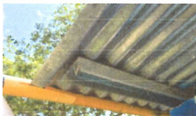
Foto 5: CANALES Y BAJADAS DE AGUA PLUVIAL Sustitución de canales para evacuación de aguas pluviales. Material: lamina galvanizada Tipo: lisa, Anclaje: canal sostenido por pescantes metalicos. En baños
